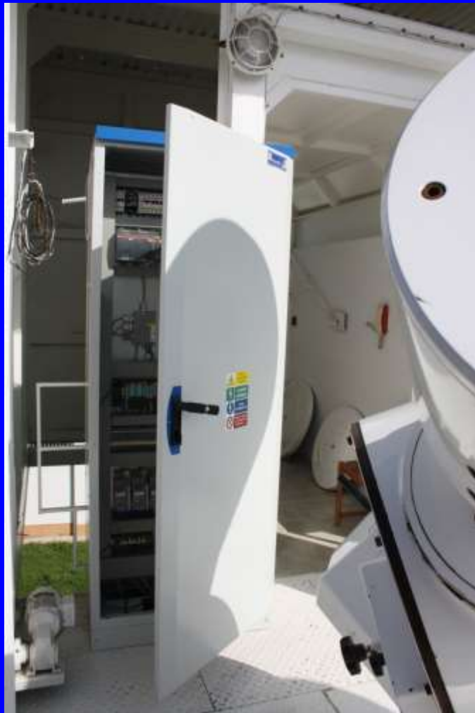
Ovládanie pohybu zrkadiel coelostatu
